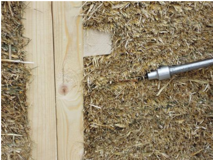
Paneele-ingeschraubt Zusammenschrauben der Paneele
