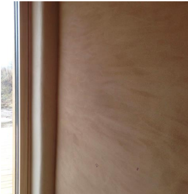
Verputzte Wand aus Stroh-Paneelen, Lehmputz und abgerundete Kanten am Fensteranschluss
