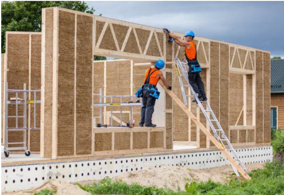
Stroh-Paneel-Struktur Sturzmontage
