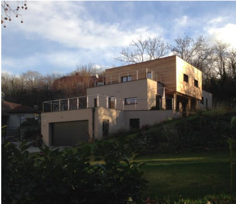
Strohballen-Plattenhaus Passivhaus jenseits der Grenze in Österreich mit Strohpneelen gebaut
