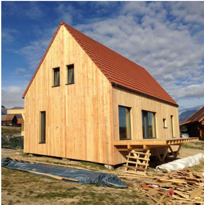
Holzverkleidung über Ballenplatten, Passivhaus in der Nordslowakei mit Strohplatten gebaut
